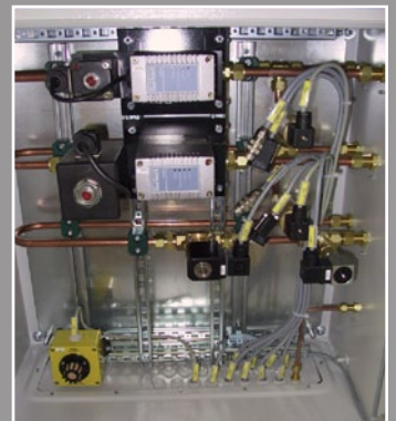
Gasregelschrank
